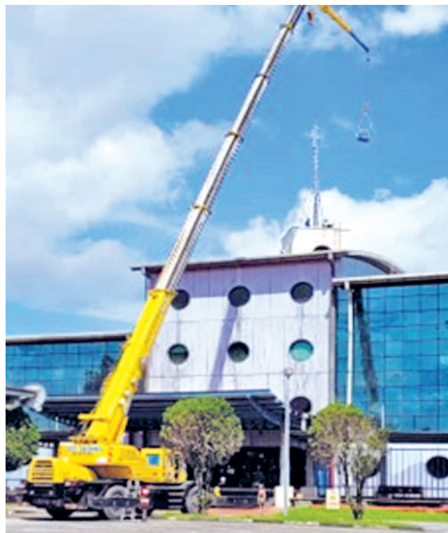
Pemasangan menara radar VTMS sedang dijalankan di Terminal Senari.
