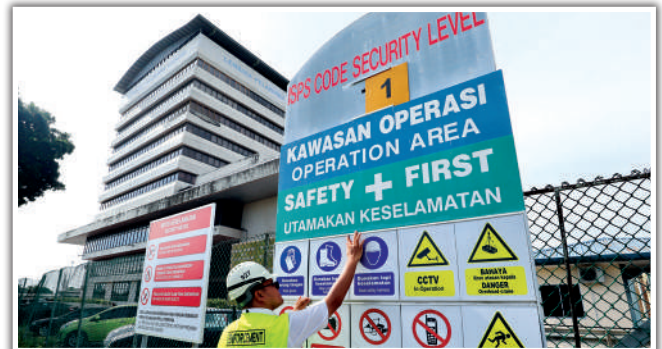
Pemasangan papan tanda keselamatan oleh Pegawai Penguatkuasa dan Kawal Selia LPK di Terminal Pending.
