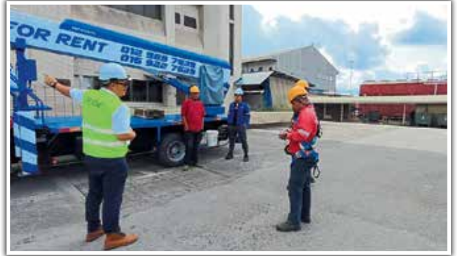
Taklimat keselamatan untuk kontraktor sebelum kerja dimulakan di Terminal Pending dan Senari. Toolbox briefing for contractors before the start of work at Pending and Senari Terminal.
